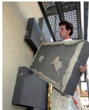
Wärmedämmung durch vorfabrizierte Dämmplatten oder durch direktes Aufschäumen.
