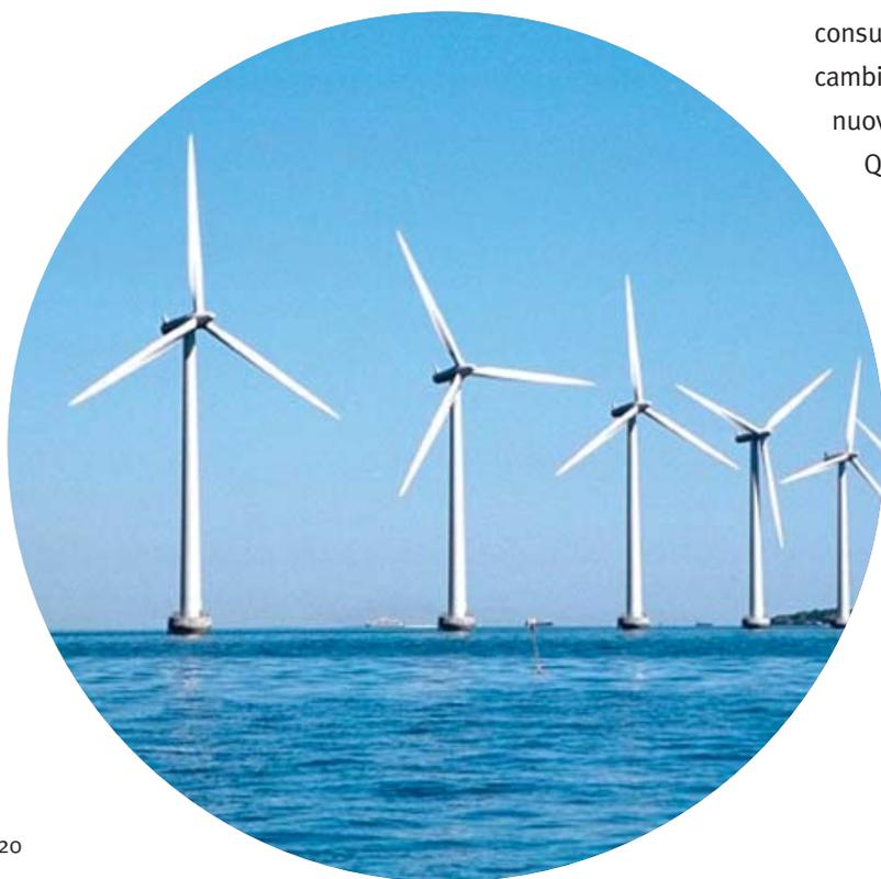
*Le moderne turbine eoliche sono realizzate utilizzando plastiche con fibra rinforzata, le pale possono così raggiungere fino a 60 metri di lunghezza.*
