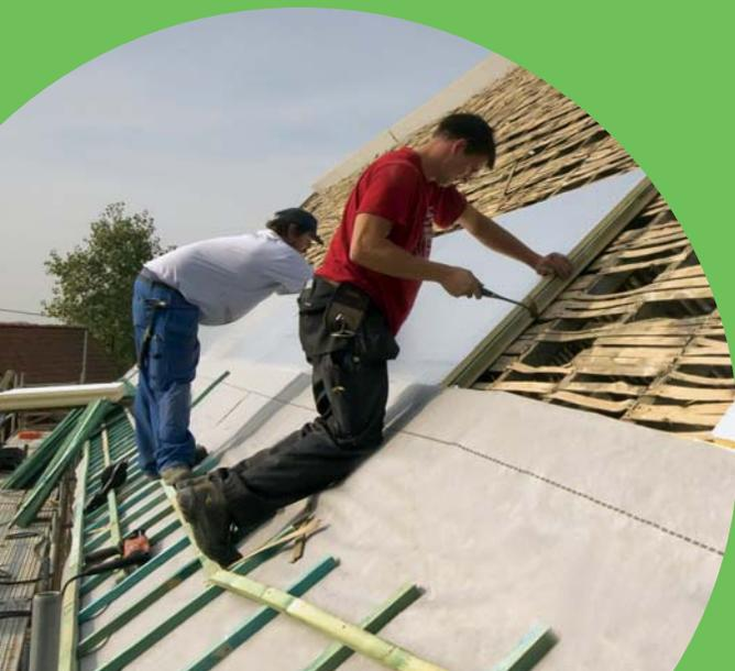
(Foto di sinistra) Installazione di pannelli isolanti in plastica.
