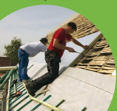
Fotografía de esta página - Instalación de un aislamiento de plástico en el tejado.
