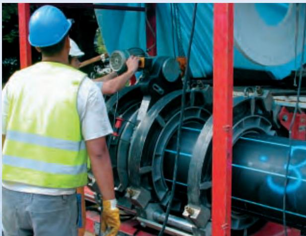
Qualité essentielle du matériau, la soudabilité permet d'assurer la continuité et l'étanchéité des réseaux par l'absence de raccords.
