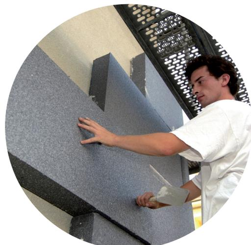
Bild – Kunststoff-Wärmedämmung für Neubauten oder zur Renovierung. Carbon innerhalb der Zellstruktur macht diese Platten wärmeabsorbierend und verbessert dadurch die Isolierung erheblich.
